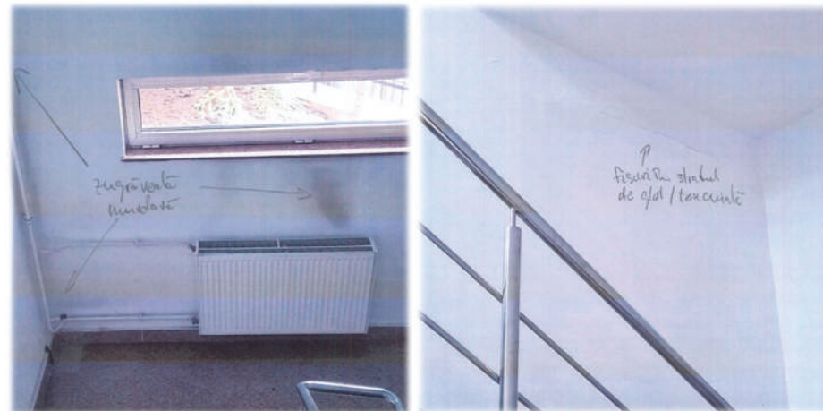
Imagini înainte execuției
